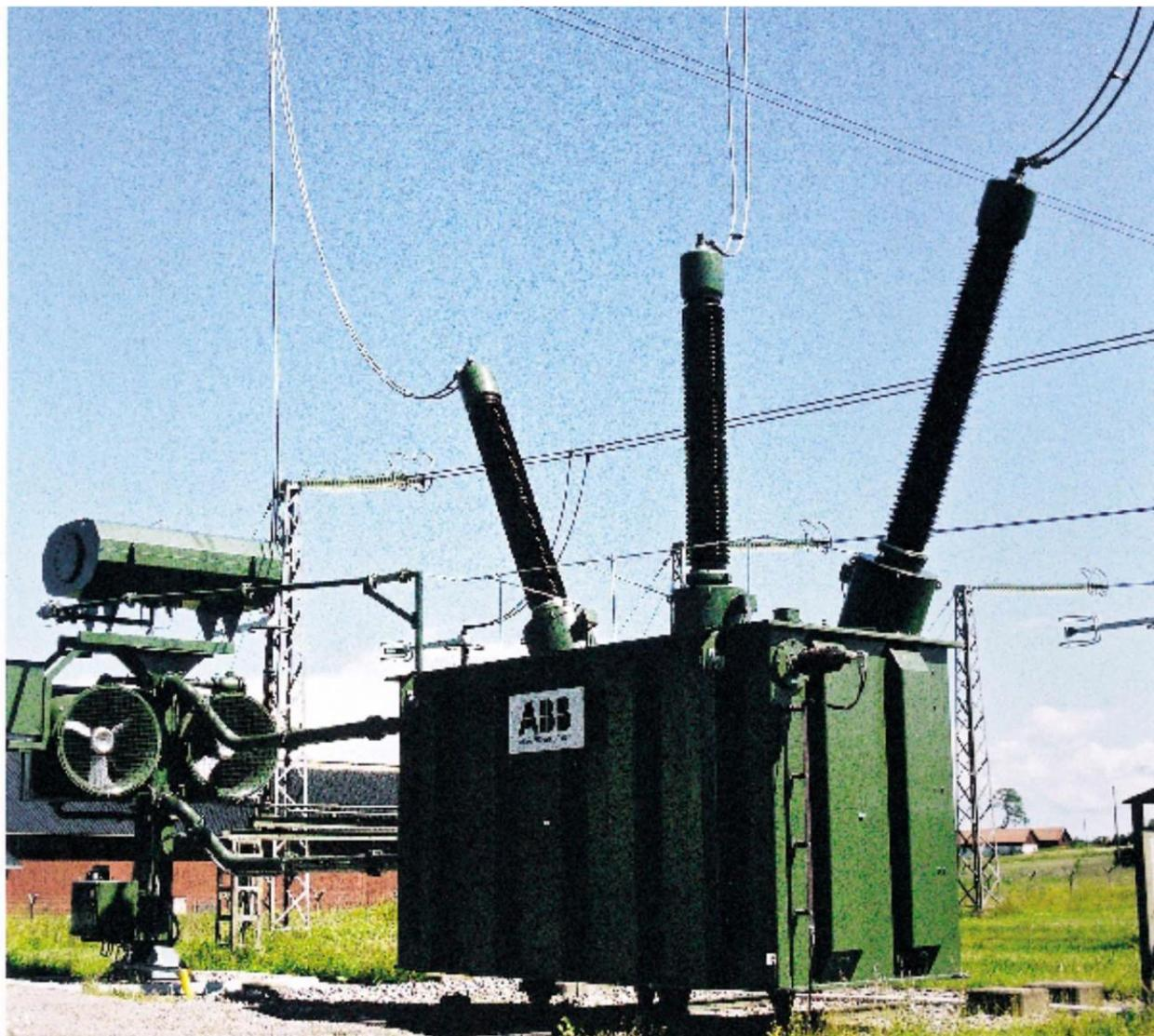
Energetski transformator je staticki uređaj sa dva ili više namotaja koji vrši transformaciju el. energije sa jednog naponskog nivoa na drugi pri istoj učestanosti radi prenosa el. energije. Sastoji se od magnetnog kola jezgra od feromagnetskog materijala i primarnog (prima energiju iz mreže) i sekundarnog namotaja (predaje energiju potrošaču).
